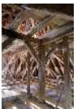
Ell.II, Dachstuhl, DI023060, BSV-
