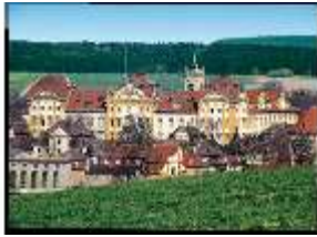
Ell.I, Ansicht der Gesamtanlage, DE003136, BSV-
