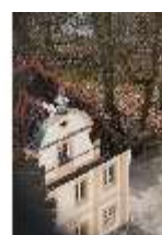
Ell.I, Blick vom Dach nach Süden, DI023140, BSV-
