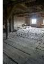
Ell.II, Dachstuhl, DI023050, BSV-
