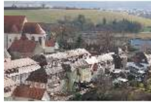
Ell.I, Blick vom Dach nach Südosten, DI023152, BSV-
