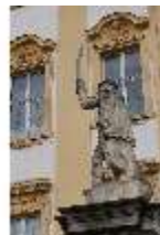
Ell.I, Südfassade, DI023034, BSV-
