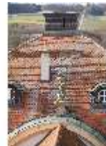
Ell.I, Blick vom Dach nach Westen, DI023137, BSV-
