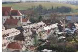
Ell.I, Blick vom Dach nach Südosten, DI023151, BSV-
