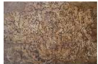
EII.II, Kabinett der Deutschordens-Ausstellung, Boden, DI022905, BSV-
