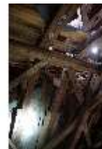
Ell.II, Dachstuhl, DI023055, BSV-
