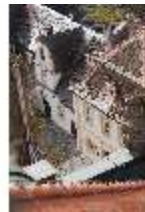
Ell.I, Blick vom Dach nach Südwesten, DI023147, BSV-
