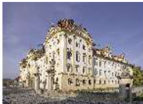
Ell.I, Fassade Stadtseite, DI015362, BSV-
