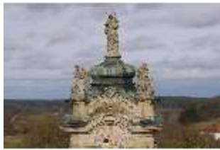
Ell.I, Blick vom Dach auf den Glockenturm, DI023144, BSV-
