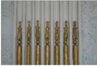
Ell.II, Festsaal, Pilaster (Det.), R. 206, DI022434, BSV-
