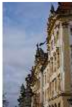
Ell.I, Südfassade, DI023024, BSV-
