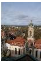
Ell.I, Blick vom Dach nach Norden, DI023097, BSV-
