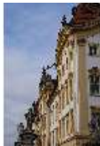
Ell.I, Südfassade, DI023023, BSV-
