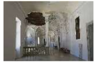
Ell.II, Treppenhaus mit Flur im 2. Obergeschoss, DI022407, BSV-
