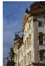
Ell.I, Südfassade, DI023025, BSV-
