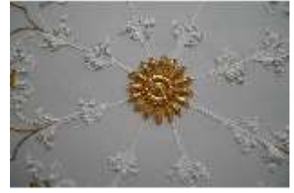
Ell.II, Festsaal, Detail der Decke, DI023078, BSV-
