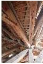
Ell.II, Dachstuhl, DI023046, BSV-
