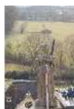
Ell.I, Blick vom Dach nach Süden, DI023132, BSV-
