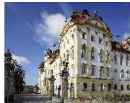
Ell.I, Fassade Stadtseite, DI015364, BSV-
