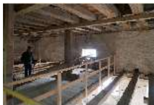
Ell.II, Dachstuhl, DI023053, BSV-
