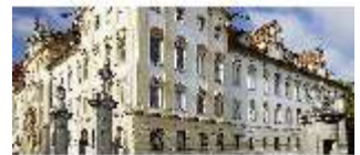
Ell.I, Fassade Stadtseite, DI015365, BSV-
