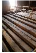
Ell.II, Dachstuhl, DI023090, BSV-
