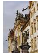
Ell.I, Südfassade, DI023027, BSV-
