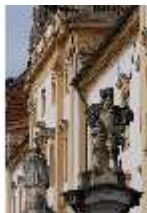
Ell.I, Südfassade, DI023028, BSV-
