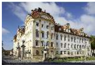
Ell.I, Fassade Stadtseite, DI015363, BSV-
