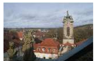
Ell.I, Blick vom Dach nach Norden, DI023093, BSV-
