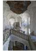
Ell.II, Treppenhaus mit Flur im 2. Obergeschoss, DI022473, BSV-
