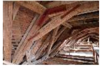
Ell.II, Dachstuhl, DI023044, BSV-
