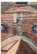
Ell.I, Blick vom Dach nach Westen, DI023138, BSV-
