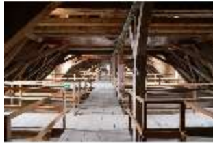
Ell.II, Dachstuhl, DI023049, BSV-
