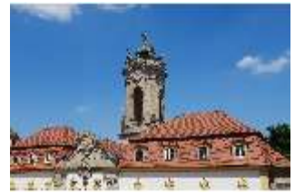
Ell.I, Dach der Schlosskirche mit Turm, DI022467, BSV-
