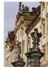
Ell.I, Südfassade, DI023032, BSV-
