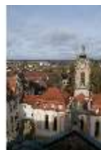
Ell.I, Blick vom Dach nach Norden, DI023098, BSV-
