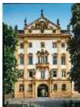
Ell.I, Mittelrisalit, Portal offen, DE001241, BSV-
