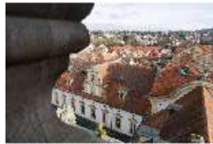
Ell.I, Blick vom Dach nach Nordosten, DI023105, BSV-
