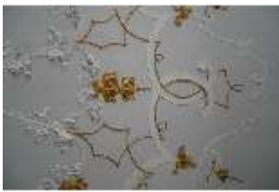
Ell.II, Festsaal, Detail der Decke, DI023079, BSV-
