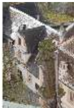
Ell.I, Blick vom Dach nach Südwesten, DI023134, BSV-
