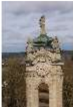
Ell.I, Blick vom Dach auf den Glockenturm, DI023146, BSV-
