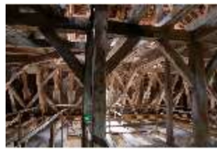
Ell.II, Dachstuhl, DI023058, BSV-
