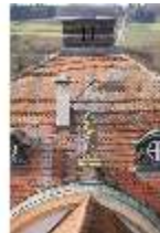
Ell.I, Blick vom Dach nach Westen, DI023136, BSV-
