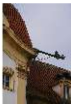
Ell.I, Südfassade mit Wasserspeier, DI023031, BSV-
