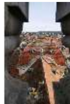
Ell.I, Blick vom Dach nach Osten, DI023102, BSV-
