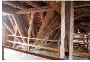
Ell.II, Dachstuhl, DI023043, BSV-
