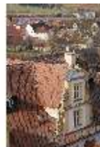
Ell.I, Blick vom Dach nach Norden, DI023120, BSV-
