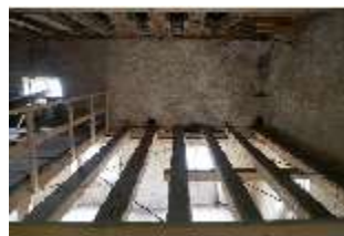
Ell.II, Dachstuhl, DI023054, BSV-
