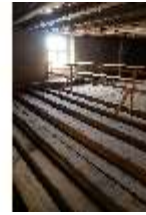
Ell.II, Dachstuhl, DI023091, BSV-
