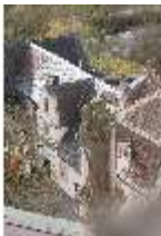
Ell.I, Blick vom Dach nach Südwesten, DI023133, BSV-
