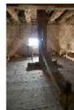
Ell.II, Dachstuhl, DI023063, BSV-
