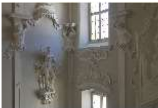
Ell.II, Treppenhaus mit Stuckfigur der Minerva, DI022395, BSV-
