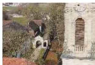
Ell.I, Blick vom Dach nach Norden, DI023117, BSV-
