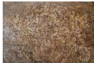
EII.II, Kabinett der Deutschordens-Ausstellung, Boden, DI022909, BSV-
