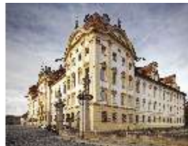
Ell.I, Fassade der Stadtseite, DI015472, BSV-
