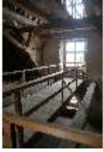
Ell.II, Dachstuhl, DI023041, BSV-
