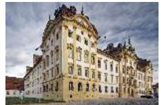
Ell.I, Fassade Stadtseite, DI015466, BSV-
