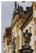
Ell.I, Südfassade, DI023029, BSV-
