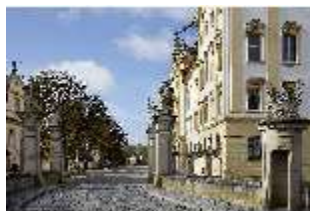
Ell.I, Fassade Stadtseite, DI015367, BSV-
