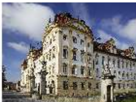
Ell.I, Fassade Stadtseite, DI015366, BSV-
