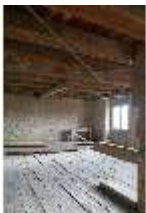
Ell.II, Dachstuhl, DI023052, BSV-
