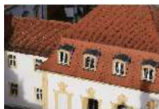
Ell.I, Blick vom Dach, Dachgeschoss, DI023142, BSV-
