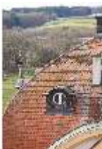
Ell.I, Blick vom Dach nach Westen, DI023149, BSV-
