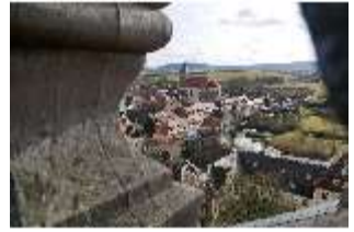
Ell.I, Blick vom Dach nach Südosten, DI023110, BSV-
