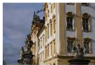
Ell.I, Südfassade und Ostflügel, DI023026, BSV-
