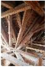
Ell.II, Dachstuhl, DI023045, BSV-
