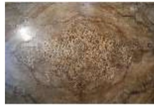
EII.II, Kabinett der Deutschordens-Ausstellung, Boden, DI022918, BSV-
