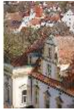
Ell.I, Blick vom Dach nach Norden, DI023145, BSV-
