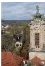
Ell.I, Blick vom Dach nach Norden, DI023116, BSV-
