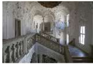
Ell.II, Treppenhaus mit Flur im 2. Obergeschoss, DI022475, BSV-
