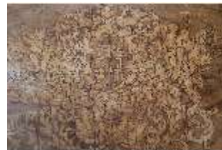
EII.II, Kabinett der Deutschordens-Ausstellung, Boden, DI022910, BSV-
