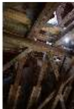
Ell.II, Dachstuhl, DI023057, BSV-
