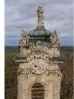
Ell.I, Blick vom Dach auf den Glockenturm, DI023118, BSV-
