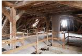
Ell.II, Dachstuhl, DI023042, BSV-
